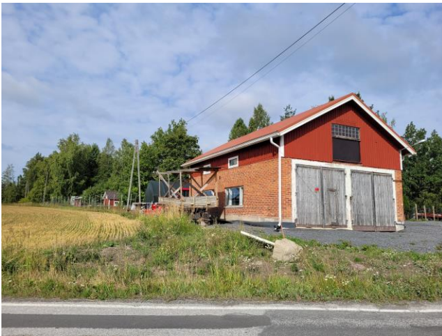
Kuva 48 Talousrakennuksessa on tiilirunkoinen alaosa, johon on puhkottu uusia ikkuna-aukkoja nykyistä käyttöä varten.
