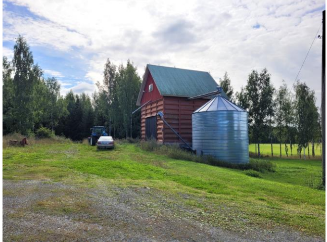
Kuva 37 1930-luvulta oleva saunarakennus on pienikokoinen ja lähimpänä Vesilahdentietä (vasemmalla). Viljasäilö on rakennuksista uusin, ja siinä on punainen profiloitu metallijulkisivu ja harkkoperustus (oikealla).
