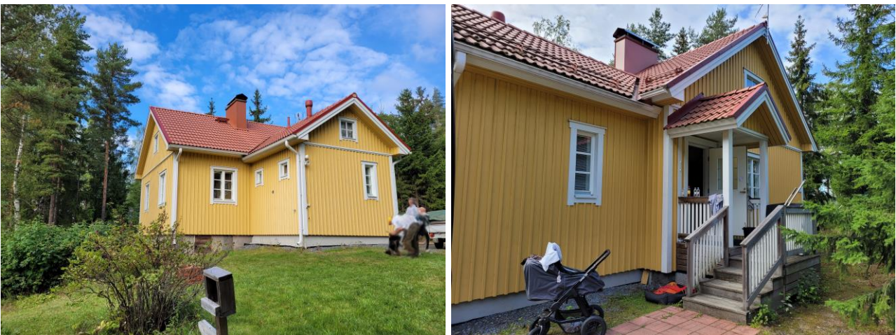
Kuva 50 Pelpon asuinrakennusta on laajennettu sisäänkäynnin viereisellä lisäsiivellä 2011.
