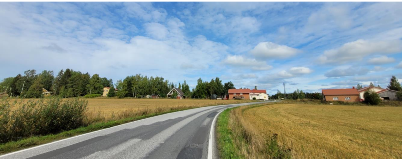
Kuva 4 Valkkistentien ja siitä haarautuvan Kilpalantien varrelle on sijoittunut suuri osa selvitysalueen rakennuskannasta.
