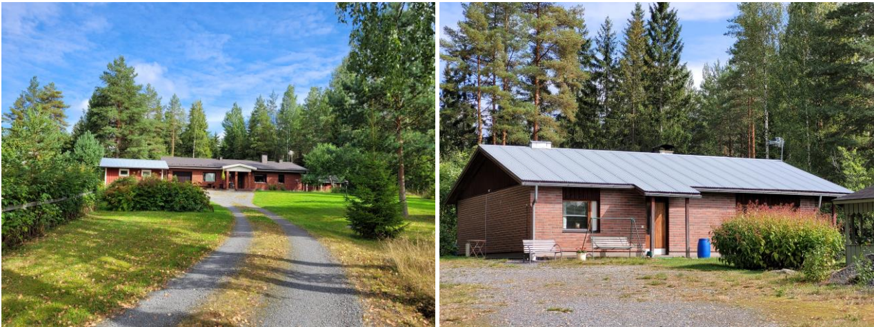
Kuva 27 Lotanmäki (vasemmalla) ja Mikanmäki (oikealla) ovat Muuranpolun varteen 1980-luvulla rakennetut tiilijulkisivuiset asuintalot.
