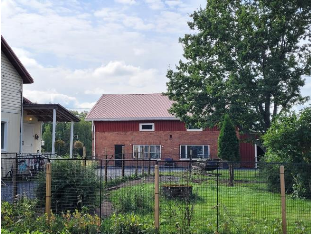
Kuva 29 Kukkaron piharakennuksessa on tiilirakenteinen alaosa, jota on laajennettu puurakenteella (vasemmalla). Haaviston suurikokoisessa talousrakennuksessa on betonilla osittain paikattu tiilirakenteinen alaosa sekä tiiliverhottu satulakatto (oikealla).
