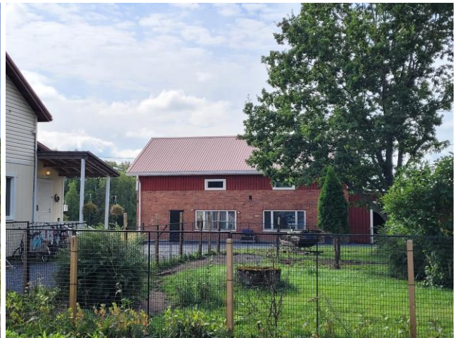
Kuva 48 Talousrakennuksessa on tiilirunkoinen alaosa, johon on puhkottu uusia ikkuna-aukkoja nykyistä käyttöä varten.
