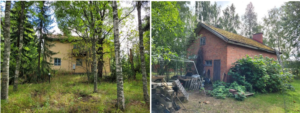
Kuva 45 Asuinrakennuksen takajulkisivu (vasemmalla) ja tiilirakenteinen talusrakennus (oikealla).
