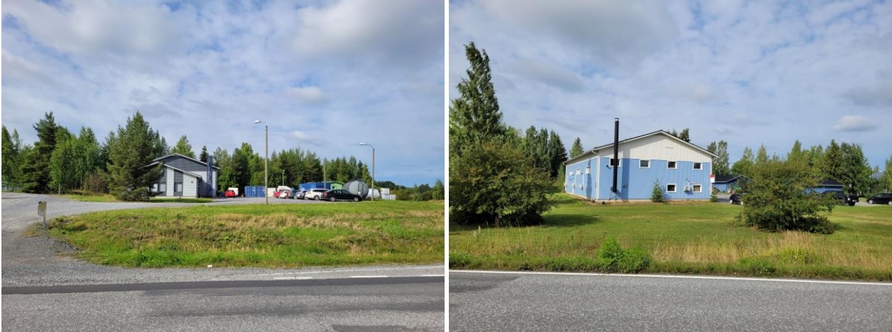
Kuva 32 Kovelonkulma (vasemmalla) ja Kovelonkulma (oikealla) ovat nykyaikaisia puurakenteisia pienteollisuusrakennuksia.
