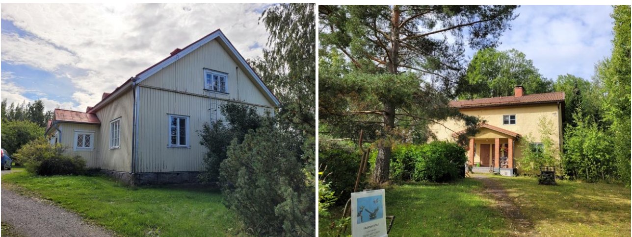
Kuva 23 Kesolan päärakennus vuodelta 1929 on alueen vanhin asuinrakennus (vasemmalla). Kovelon III:n päärakennus 1950-luvulta puolestaan on alueella poikkeava kohde sen julkisivurappauksen ansiosta (oikealla).
