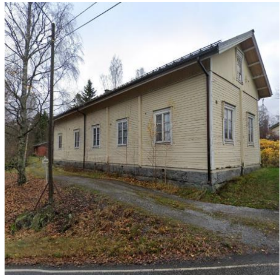
Kuva 3. Kunnanviraston Alatalon vanha, suojeltava osa kuvattuna lounaasta Rautialantieltä.
