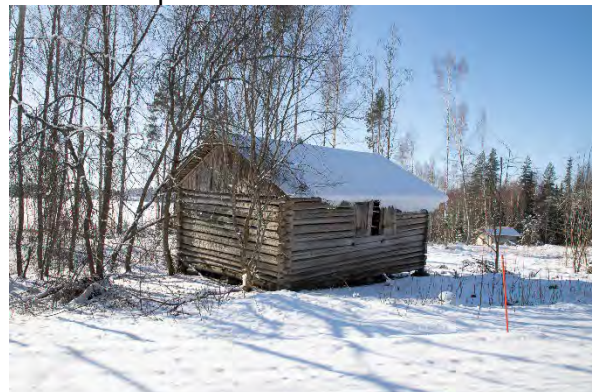
Lato lähellä Hinsalantietä. Ladon rakentamisajankohta ei ole tiedossa.
