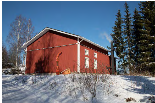
Lämpökeskusrakennus kiinteistön Keskitalo 922-405-2-35 alueella. Rakennus on rakennettu vuonna 2018. Käytetty rakennusoikeus on 201 kem 2 .
