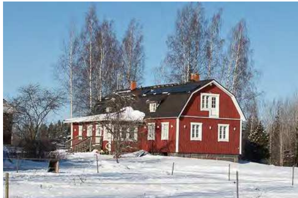
Asuinrakennus kiinteistön Keskitalo 922-405-2-35 alueella. Alun perin 1900-luvun alkupuolella rakennettu rakennus on laajennettu ja muutettu nykyiseen ulkoasuunsa vuonna 2017. Käytetty rakennusoikeus on 192 kem 2 .
