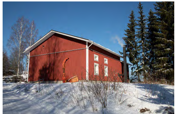
Lämpökeskusrakennus kiinteistön Keskitalo 922-405-2-35 alueella. Rakennus on rakennettu vuonna 2018. Käytetty rakennusoikeus on 201 kem 2 .
