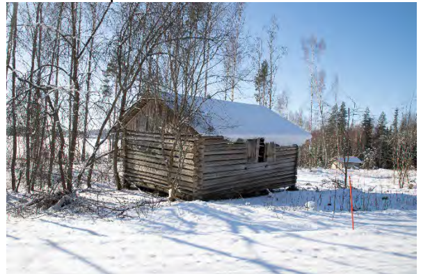
Lato lähellä Hinsalantietä. Ladon rakentamisajankohta ei ole tiedossa.
